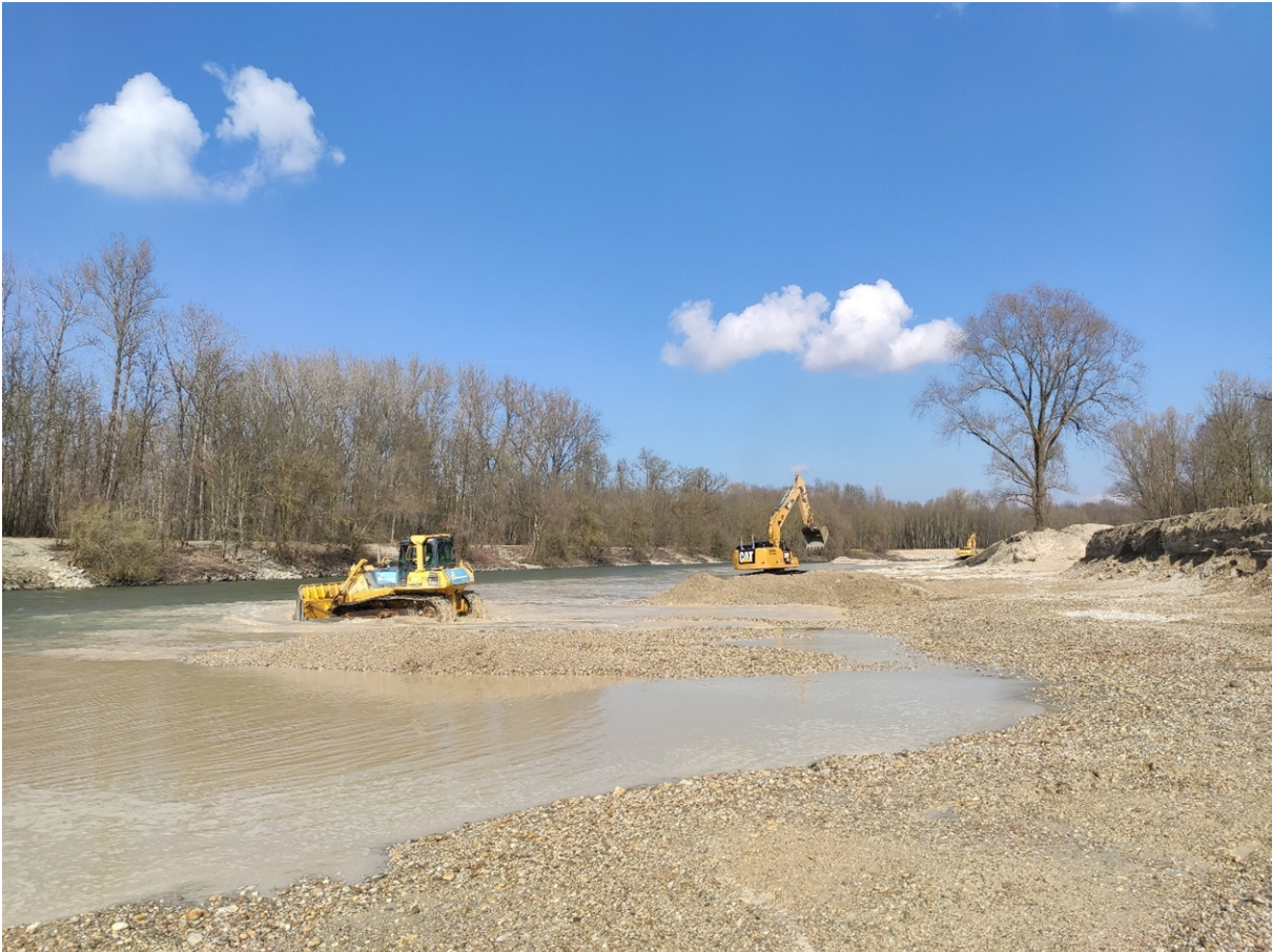
Abbildung 2: Herstellung von kiesigen Flachwasserzonen im Zuge des LIFE Natur-Projektes Fluss erleben Isar, Foto WWA Landshut
