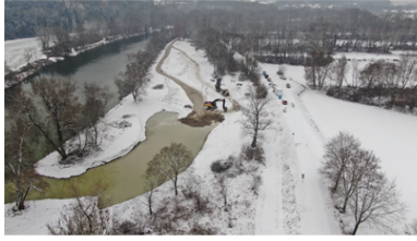
Isar-Nebenarms im Bau In Blickrichtung stromauf
