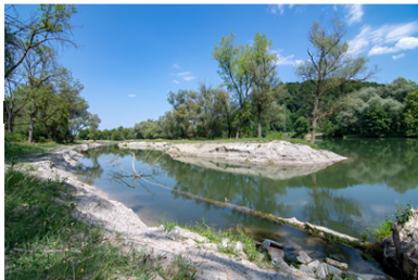
Der neu geschaffene Isar-Nebenarm am linken Isarufer in Niederaichbach; Blickrichtung stromab.
