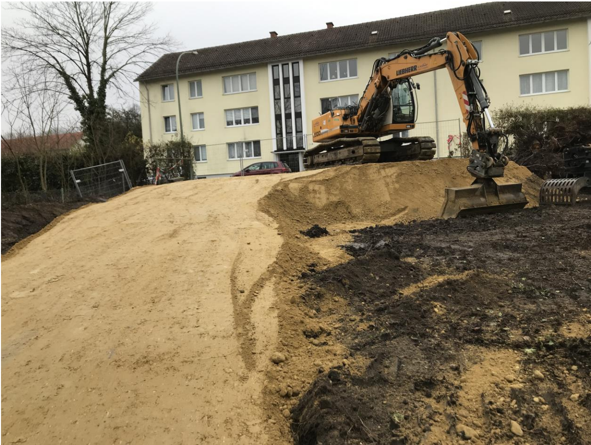
Foto 1: angelegte Baustraße (WWA LA)
