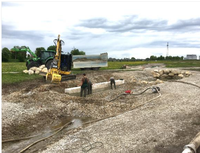
Wasserbauer des Wasserwirtschaftsamtes Landshut beim Bau der Kneippanlage in der Flutmulde (Foto: WWA LA)
