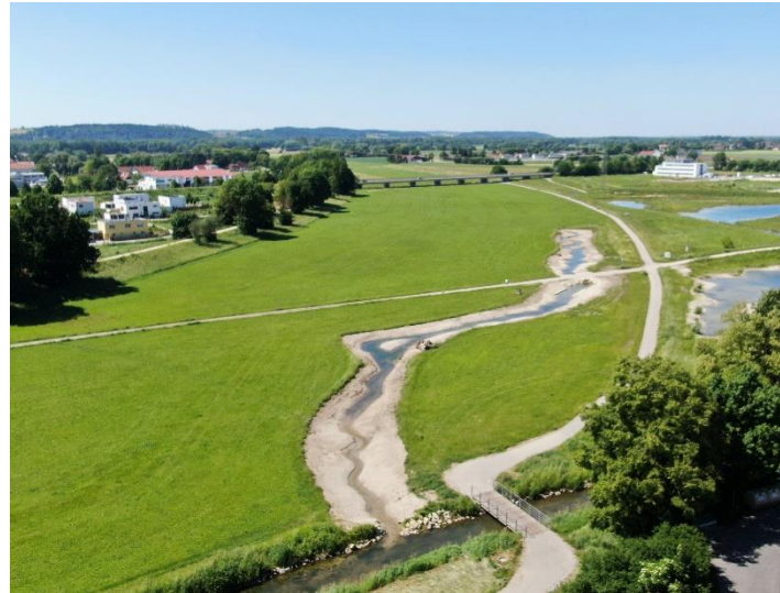
Blick von oben auf den freigelegten Abschnitt der Drainageleitung im ersten Bauabschnitt (Foto: WWA LA)
