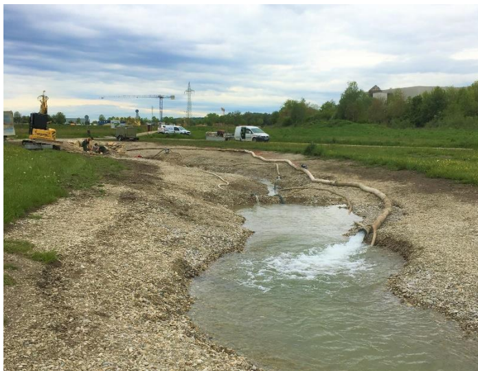
Wasserhaltung während des Baus der Kneippanlage (Foto: WWA LA)
