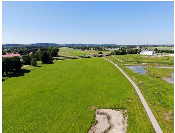
Blick auf die für den 2. Bauabschnitt vorgesehene Fläche (Foto: WWA LA)
