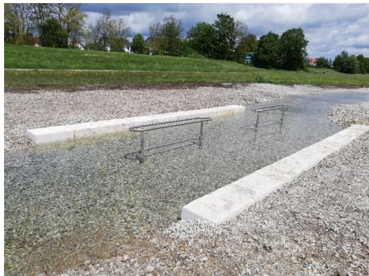
Das Kneippbecken kurz nach dem Einbau der Handläufe und der Sitzquader (Foto: WWA LA)
