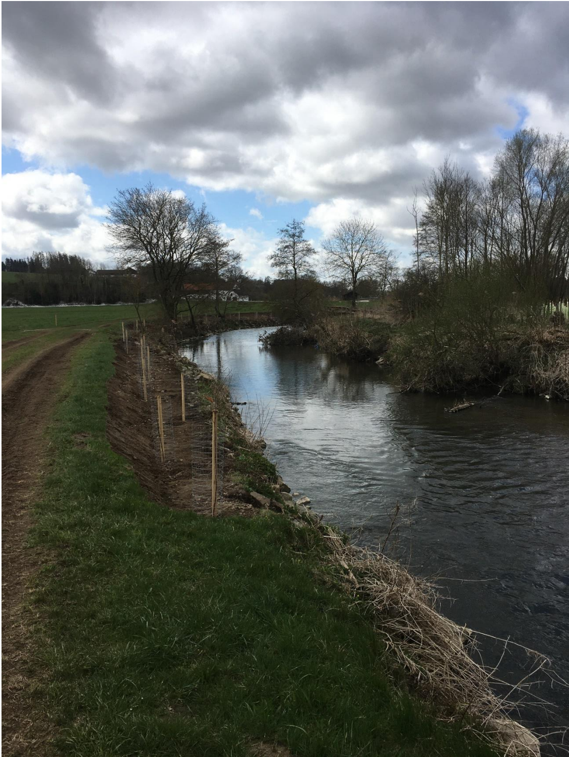
Bild 1: Abtrag der Ufer und Baumpflanzung
