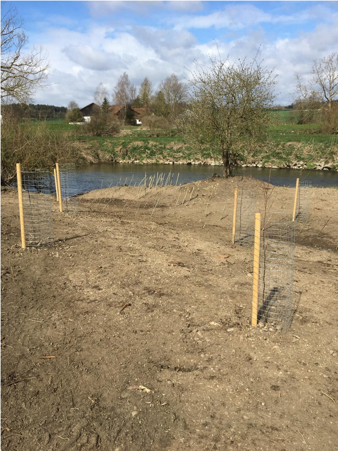
Bild 2: Abtrag der Ufer und Pflanzungen
