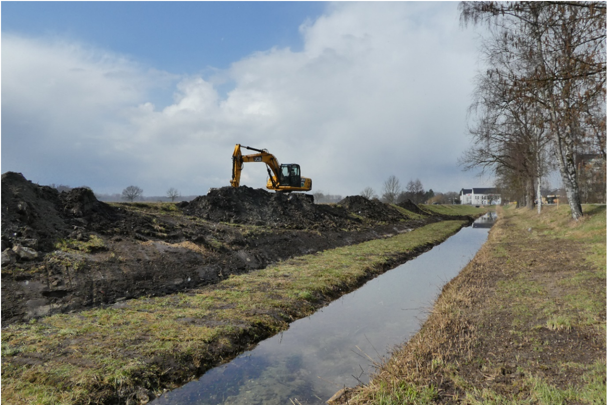
Abbildung 1 - Foto von den Unterhaltungsarbeiten (Blick vom Randkanal Richtung Staatsstraße St 2233)
