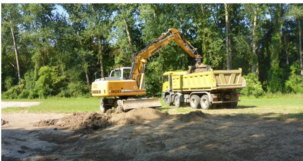
Bodenabtrag und Modellierung eines Flachwassertümpels im Teilgebiet Ettlting
