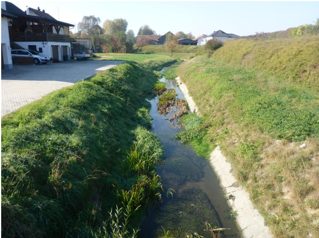
Abb. 1 Ist-Situation 2018 im Ortsbereich Saal an der Donau: begradigter Bachlauf ohne Struktur mit Uferbefestigung (Foto: BÜRO DR. H. M. SCHÖBER)
